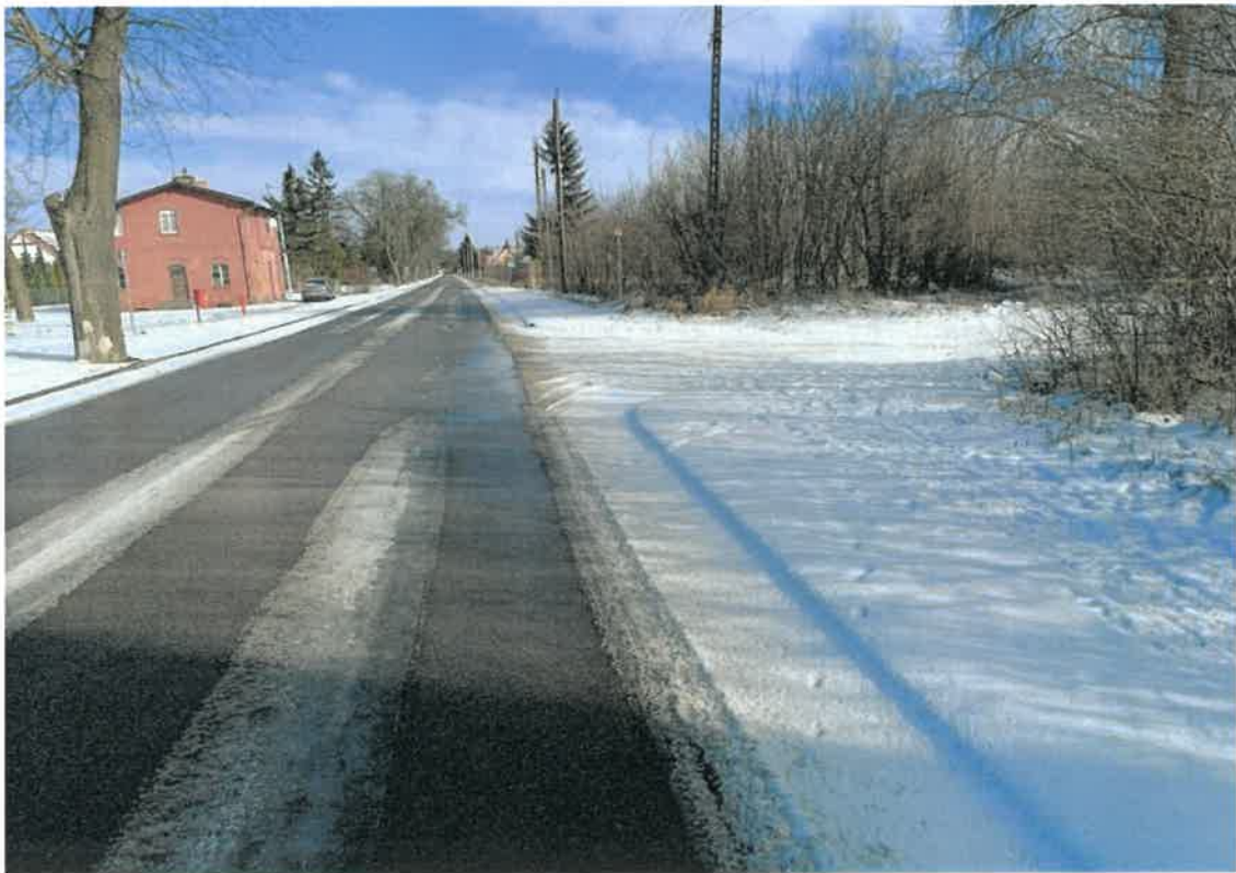
Droga do stacji kolejowej i chodniki w okolicy – Lisewo Malborskie
