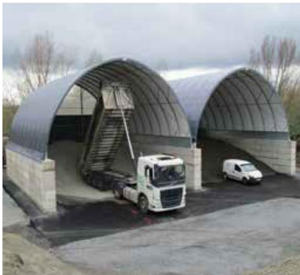
Rysunek 15: Rozładunek w obrębie hali tunelowej z samochodu samowyładowczego
